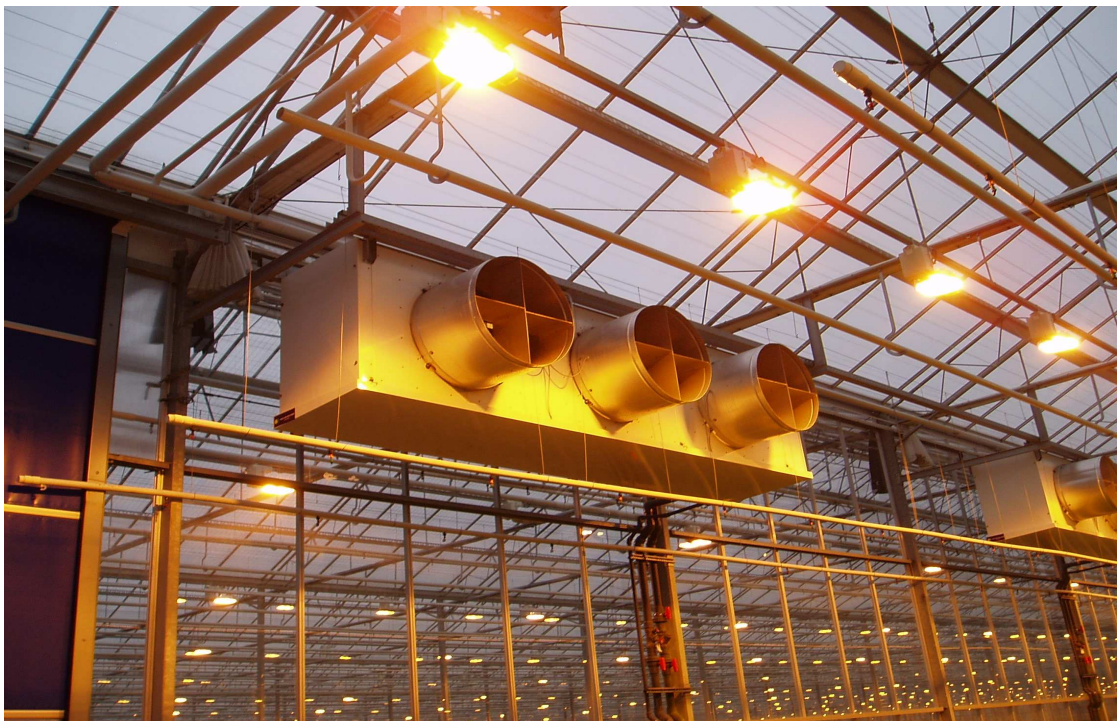
Standard køle/varmeunit til ophængning under tagfladen.
