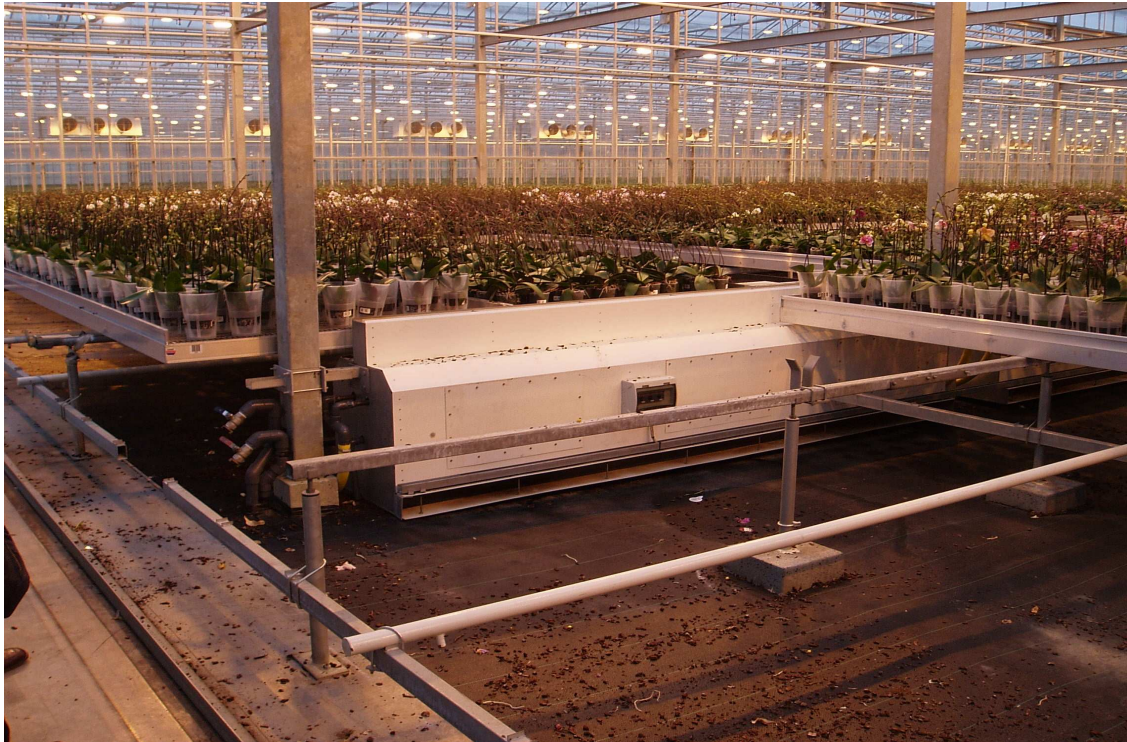
Speciel designet ventilationsunit med køle- og varmeplader til montering mellem væksthushets søjlerækker.
